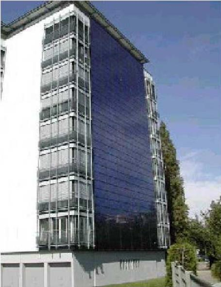
*fig. 5. – esempio di integrazione di pannelli fotovoltaico nell'edificio -*
