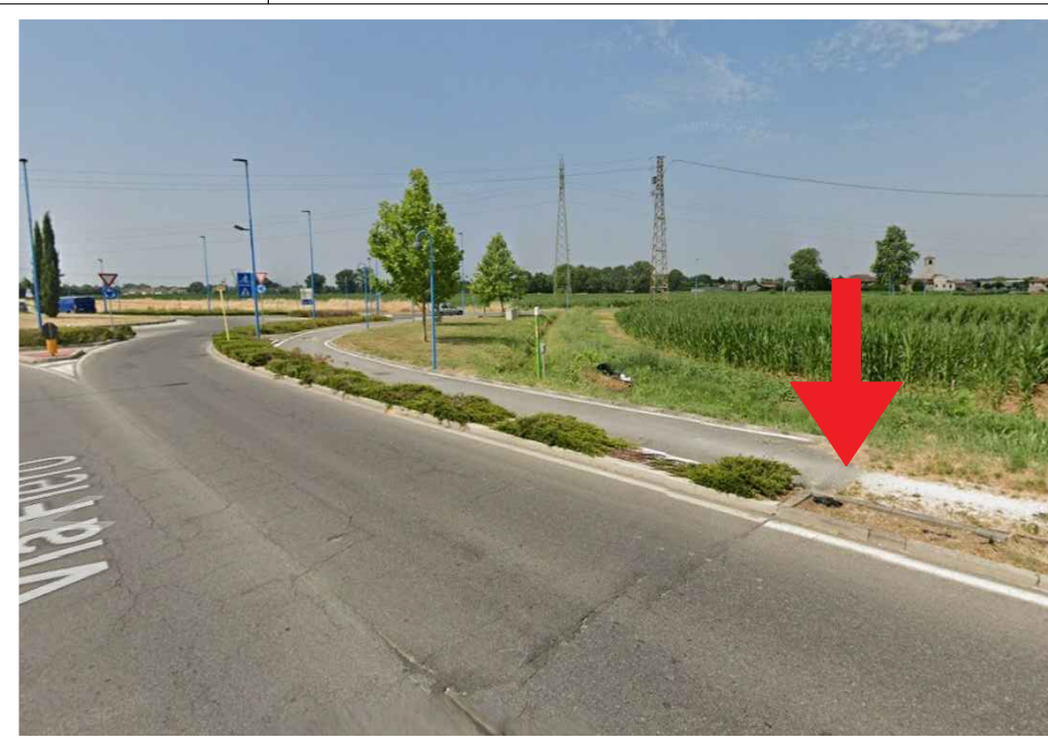
VISTA DA VILL. SERENO VERSO FLERO, INIZIO TRATTO PISTA CICLABILE STERRATA IN PROSSIMITA' DELLA ROTATORIA CON COLLEGAMENTO PISTA CICLABILE ESISTENTE
