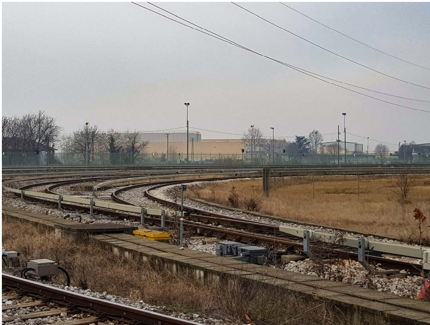
FOTO 3) VISTA DA VIA BUFFALORA ZONA DEPOSITO METRO
