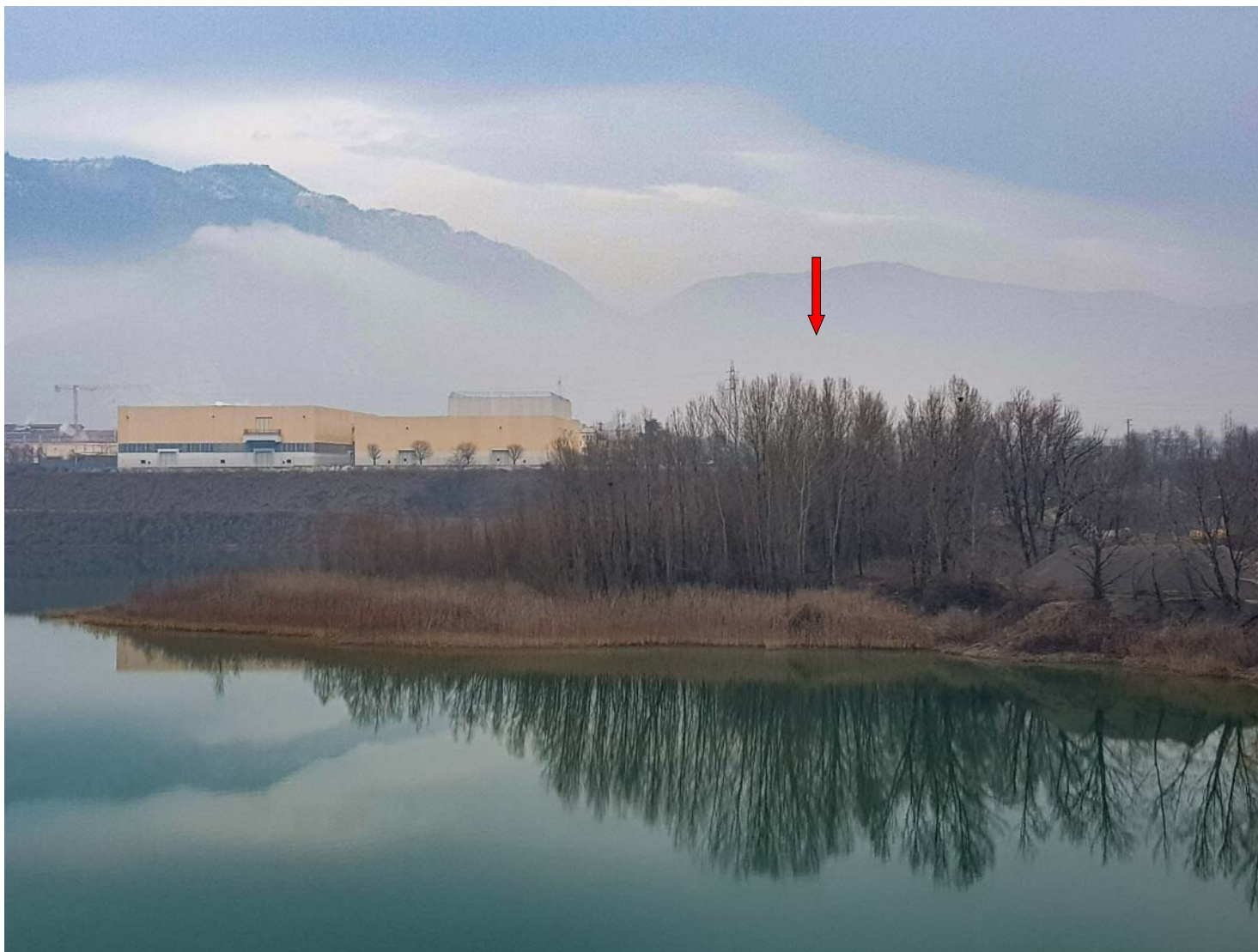
FOTO 1) VISTA DALLA TANGENZIALE
