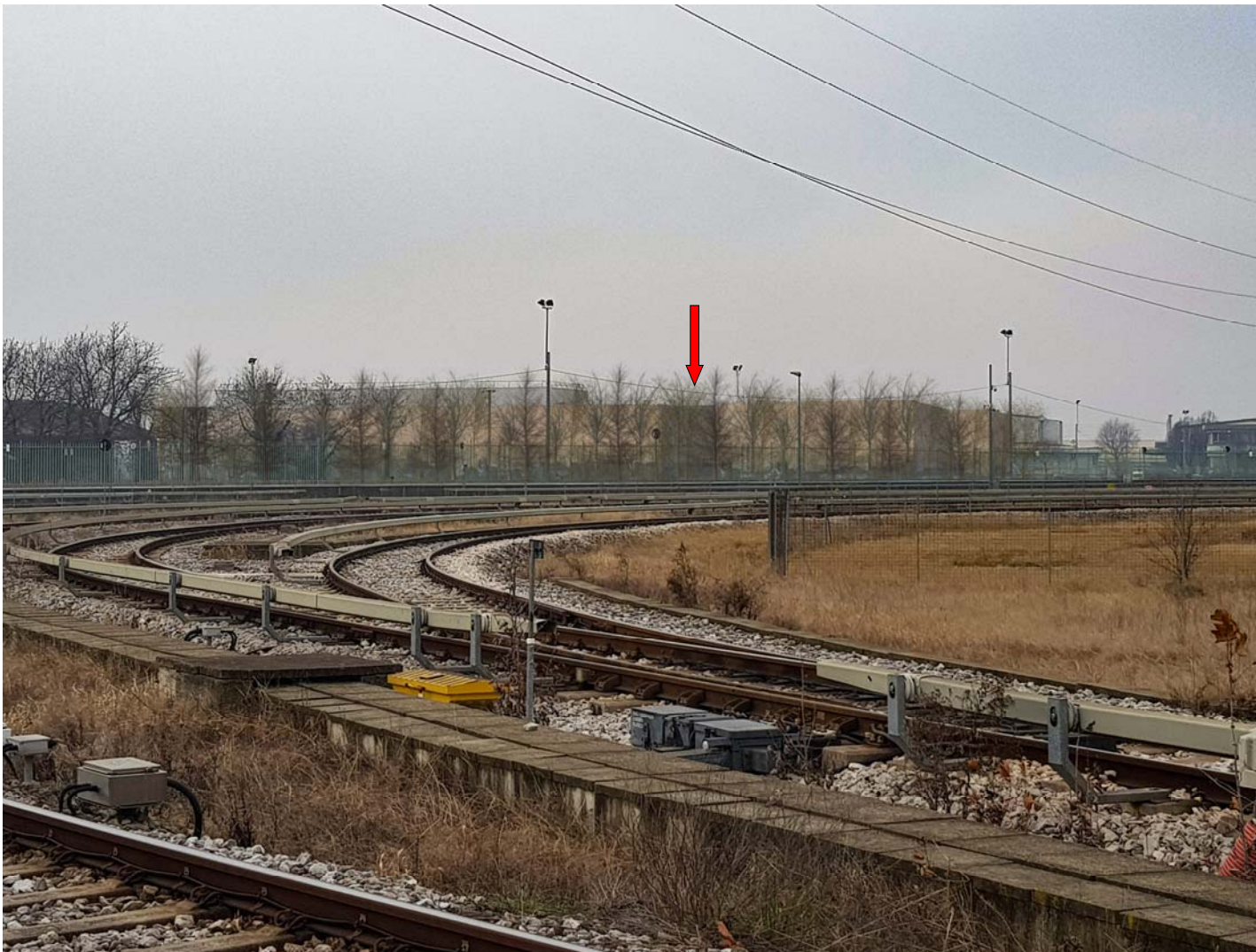
FOTO 3 S) SIMULAZIONE FOTOGRAFICA CON VISTA DA VIA BUFFALORA ZONA DEPOSITO METRO
