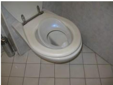
**descrizione:** riduttore per wc da utilizzare sotto l'asse per il bloccaggio
