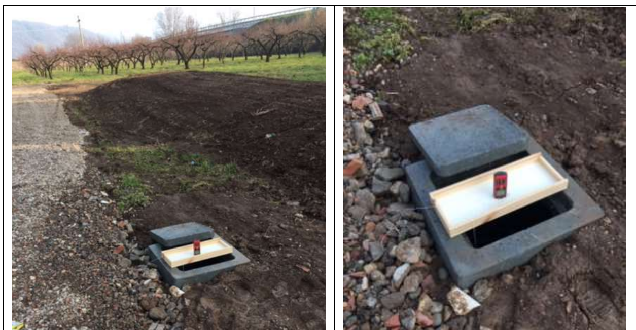
Figura 15 – Ubicazione e predisposizione pozzetto di prova
