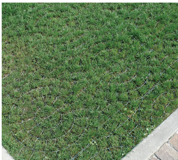
Modalità realizzative delle pavimentazioni dei parcheggi (piastrelle drenanti idonee al rinverdimento)
