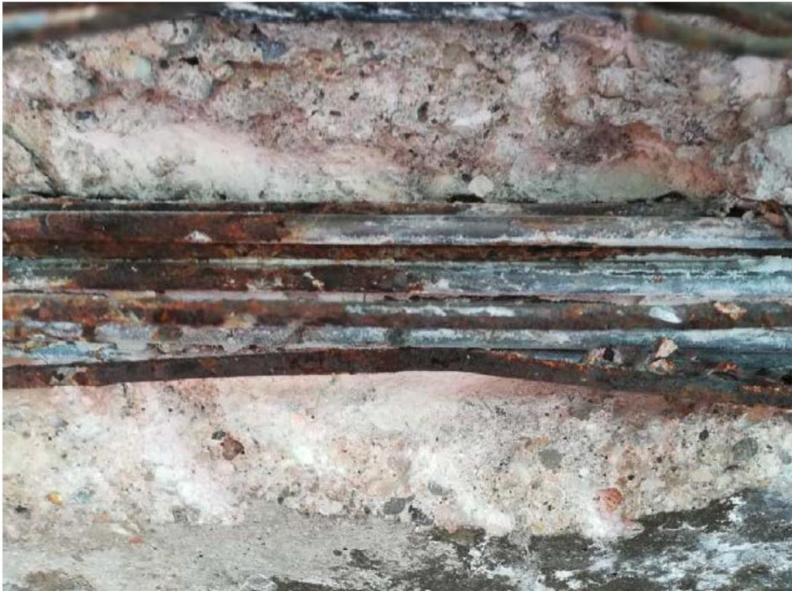
*Figura 2 – si intravede, oltre il primo strato di fili corrosi, il fascio di fili precompressi.*
