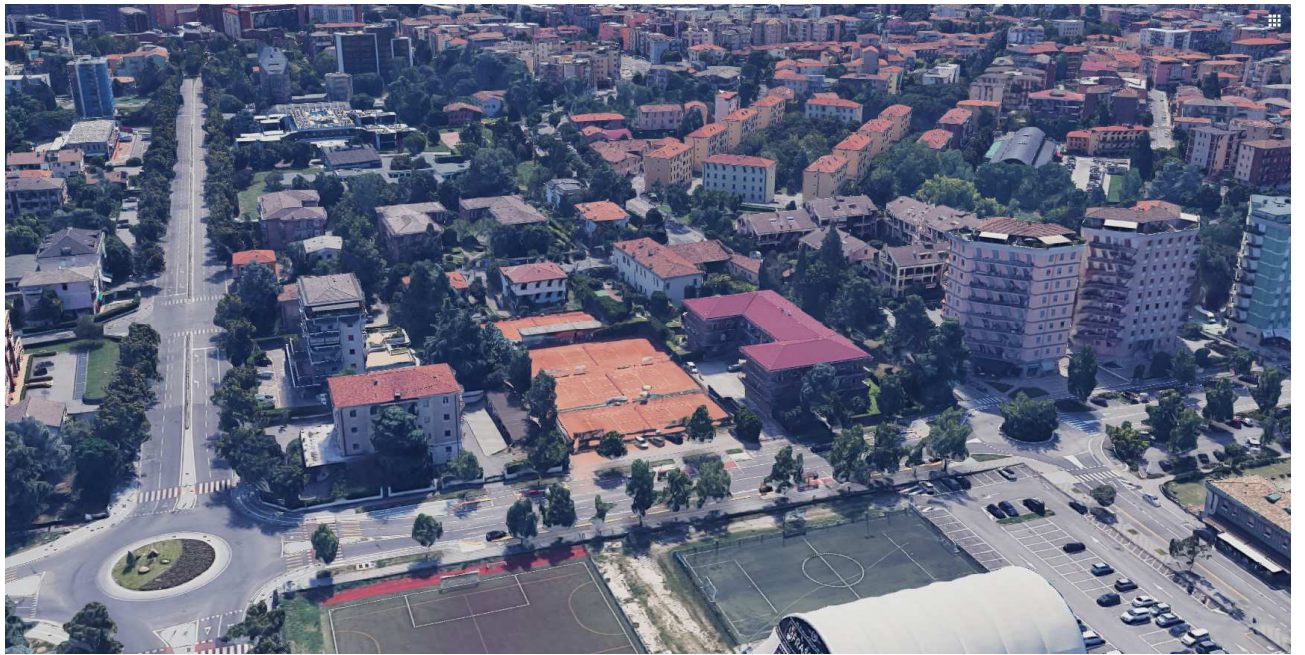
Foto 1 – Da Ovest verso Est
